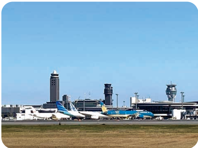
成田空港(第1ターミナル)
