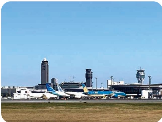
成田空港(第1ターミナル)
