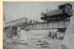
栗山川橋梁工事
