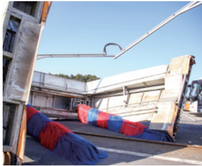
倒壊した千葉交通のバス洗車機
