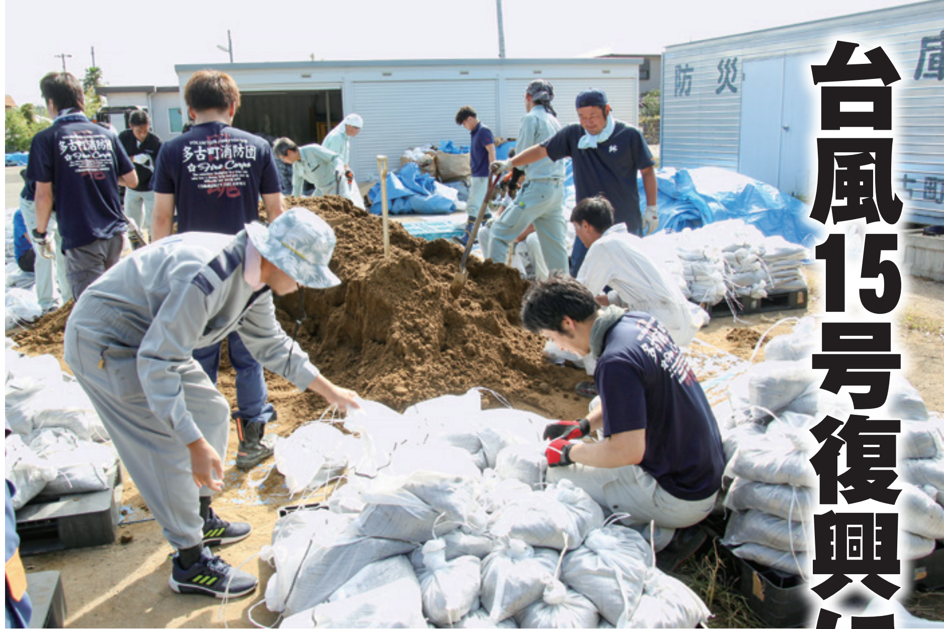
町・ボランティア・消防団、みんなで協力しての土のう作り
