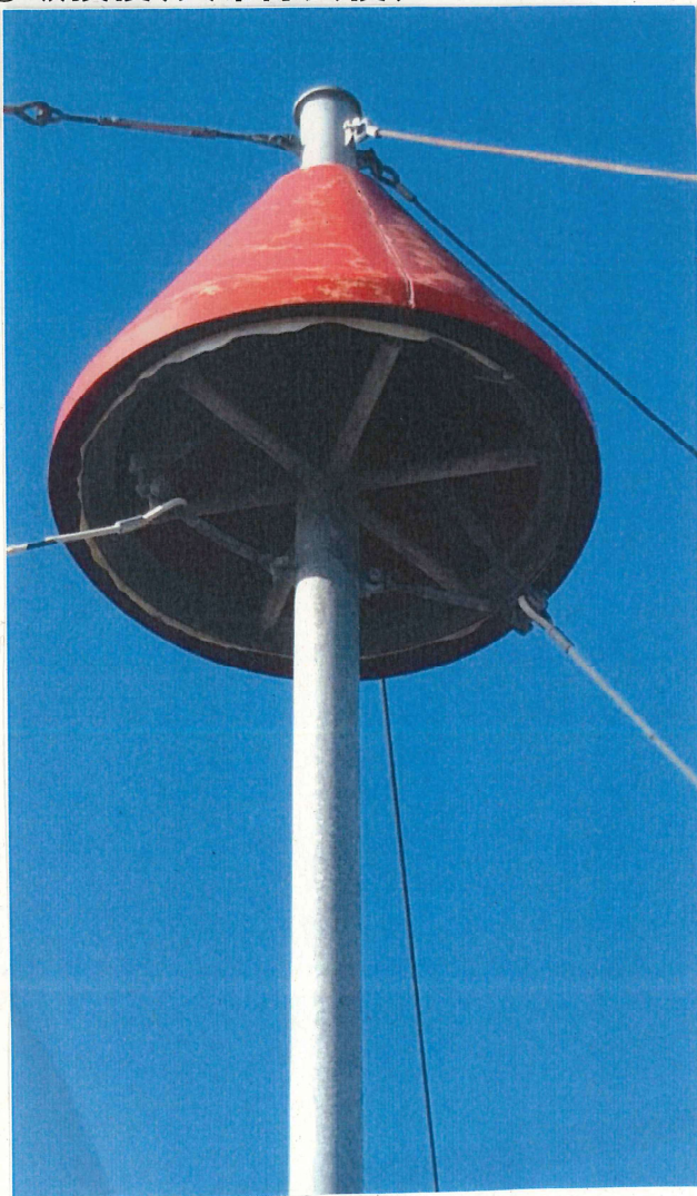
⑫破損後(天幕除去後)
