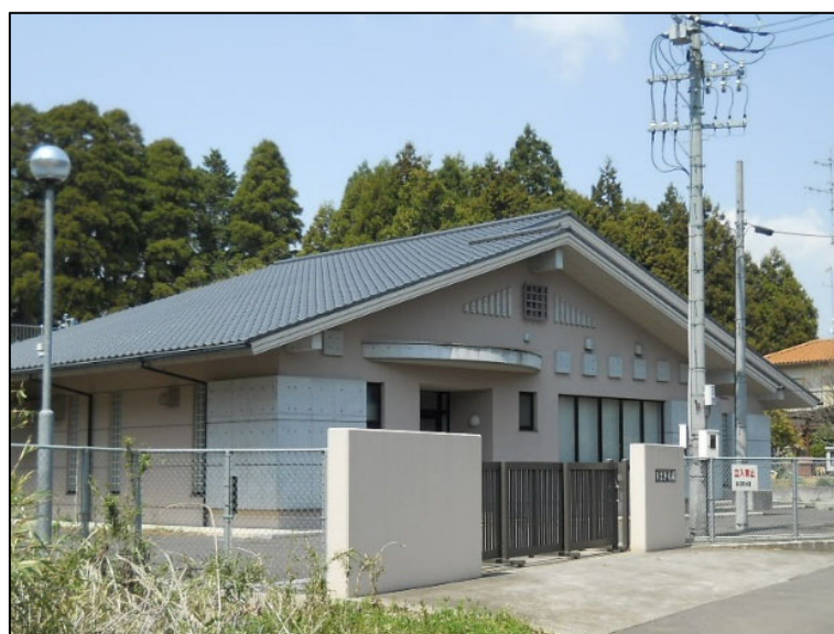
多古浄水場 管理棟
