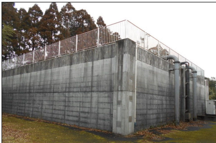
多古浄水場 配水池
