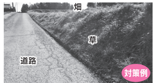
法面の草をできるだけ残す
