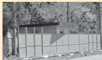
←多古第3取水井を建替え、設備を更新します。(写真は現在のものです)
