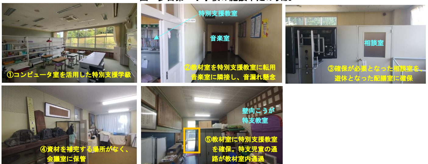
図一 多古第一小学校の施設不足の状況
