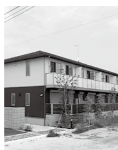
周辺の道路整備が待たれるすくすくテラス多古
